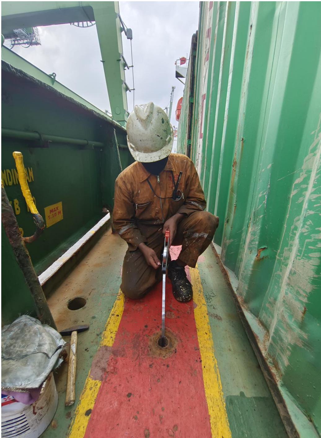
Lampiran 11 Pengecekan tangki-tangki menggunakan Alat Sounding Manual
