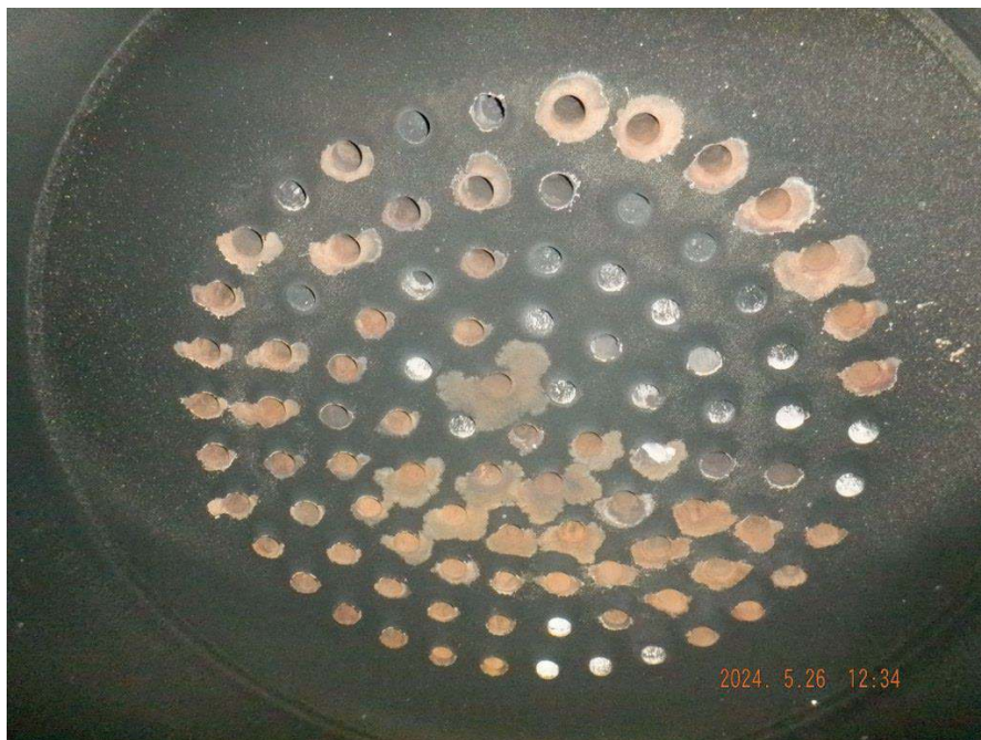
Pengecekan dan pembersihan fire tube pada boiler
