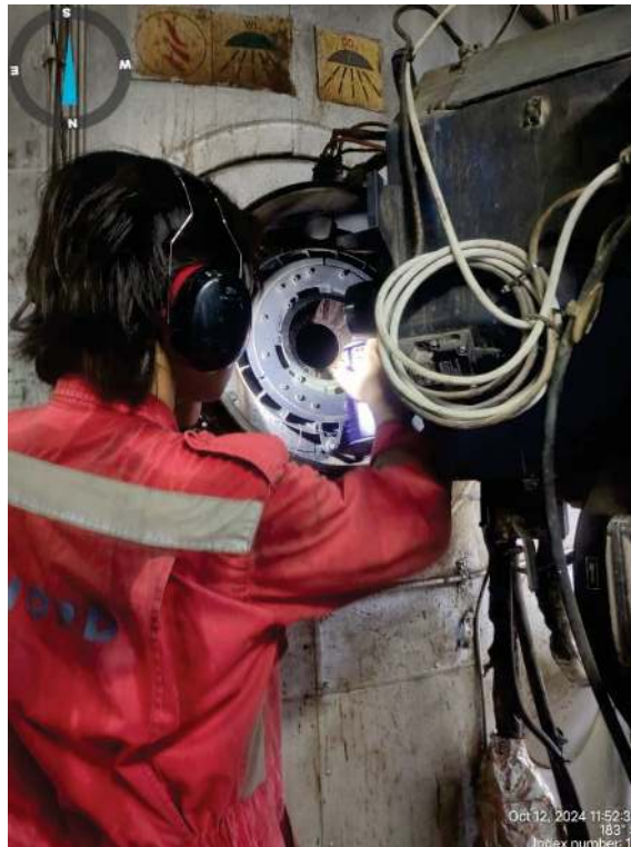
Pengecekan dan pembersihan boiler burner
