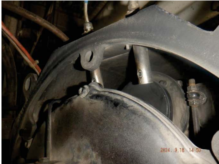
Pembersihan dan pengecekan flame eye
