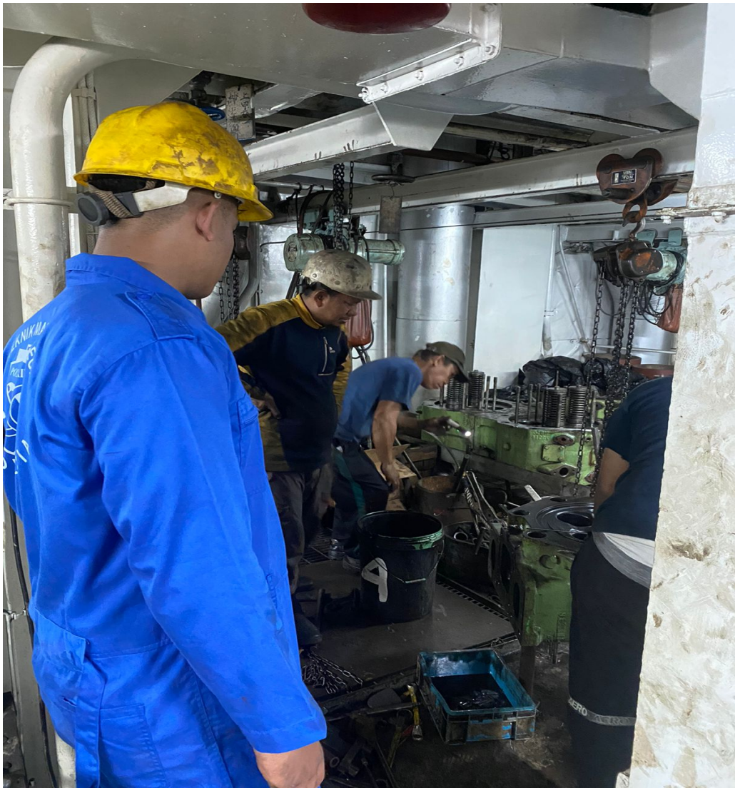
Gambar 5.6 Pelepasan katup
