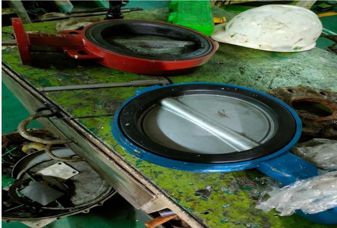
Lampiran 1. 11 Seal Actuator Valve setelah diperbaiki
